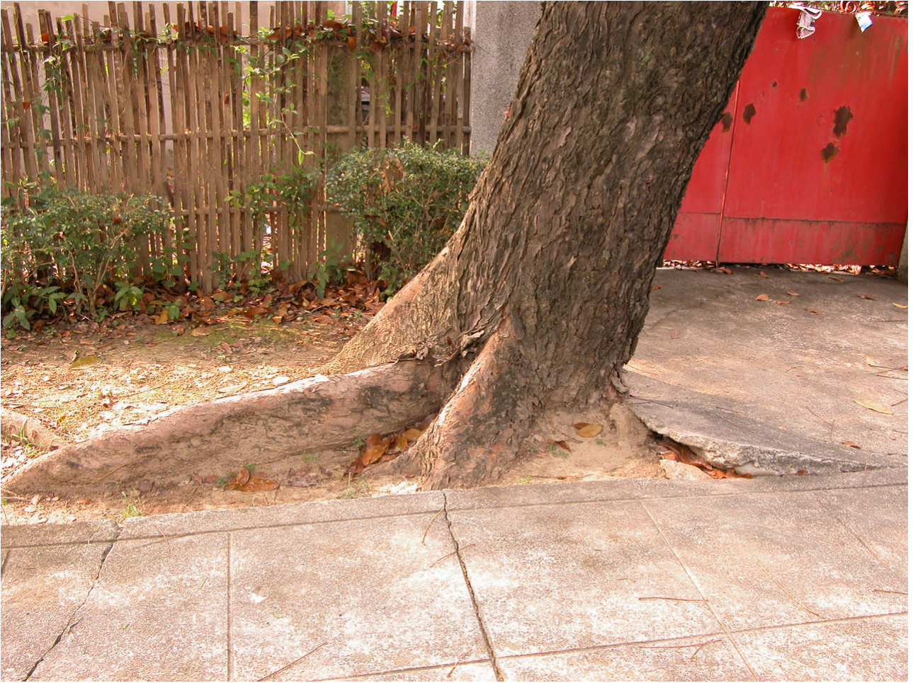
圖 5 大葉桃花心木的板根伸入鋪面下方，將鋪面翹起
