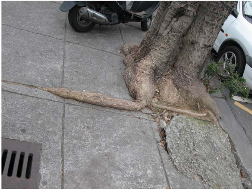
圖 3. 刺桐的粗根毀損鋪面
